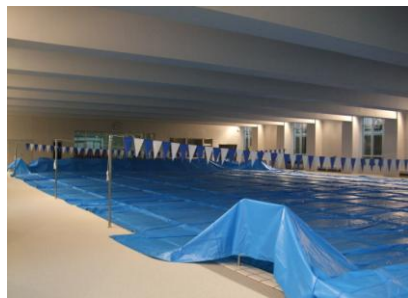
内部(ブルーシートが掛けてあります)
